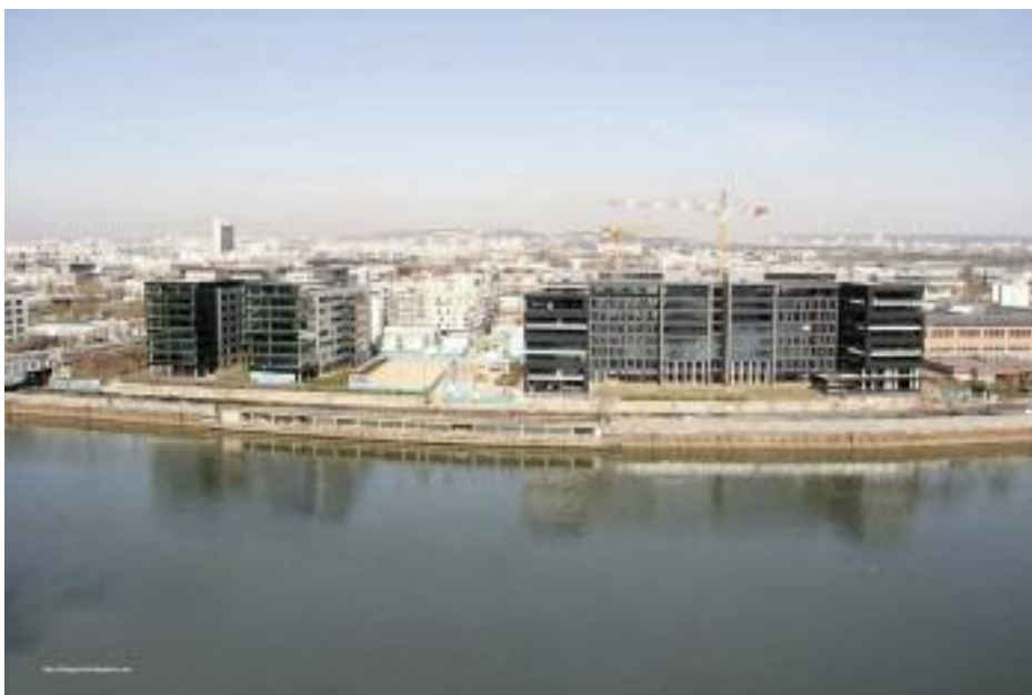
Les immeubles Front Office et O2. (Source : Service Urbanisme)
